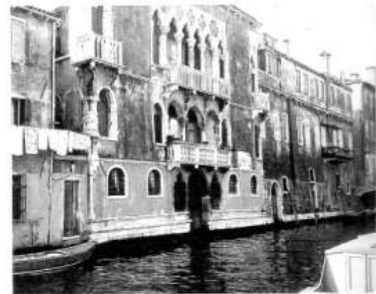
3. Palazzo del Cammello sul rio della Madonna dell'Orto, facciata nord. A destra, adiacente al palazzo, l'antica Scuola dei Fornai (n. 3378) rialzata in tempi recenti, cui succede la casa n. 3377
